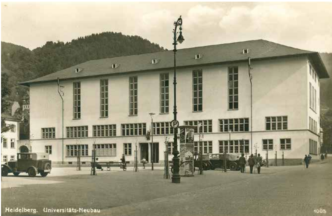
Universitätsgebäude Heidelberg, um 1930 (HStAD R 4 Nr. 17297)
