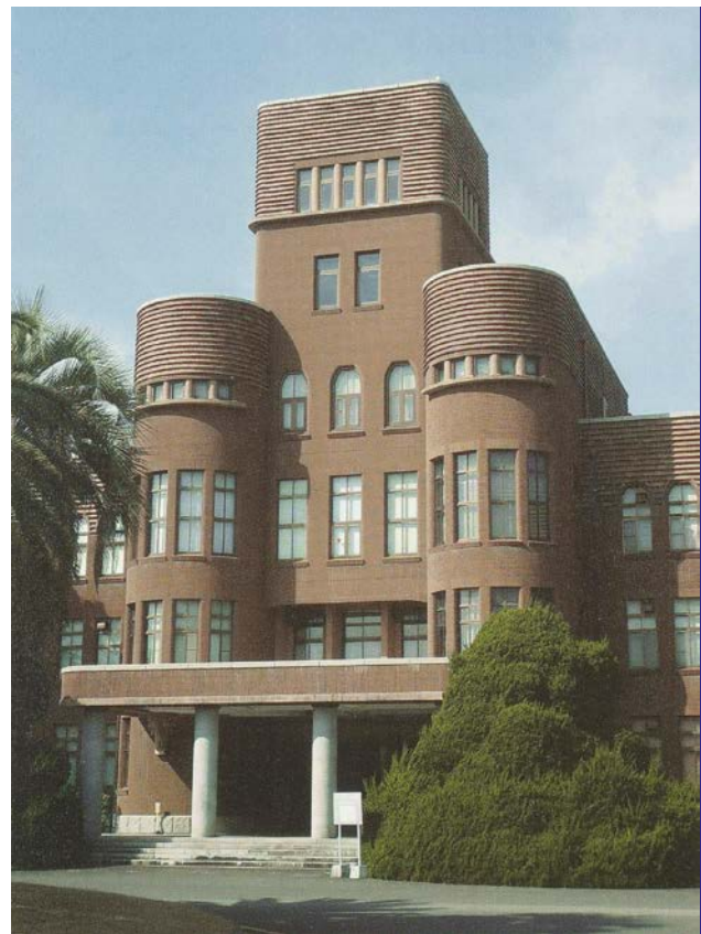
Sitz des Universitätsarchivs Kyushu im historischen Gebäude der Fakultät für Ingenieurwissenschaften aus den 1930er Jahren
